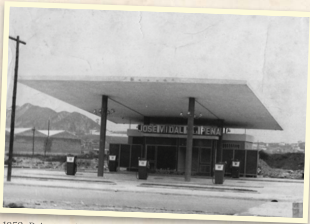
1953. Primeras instalaciones de la gasolinera de la Avenida Parayas, propiedad de la familia Vidal de la Peña
