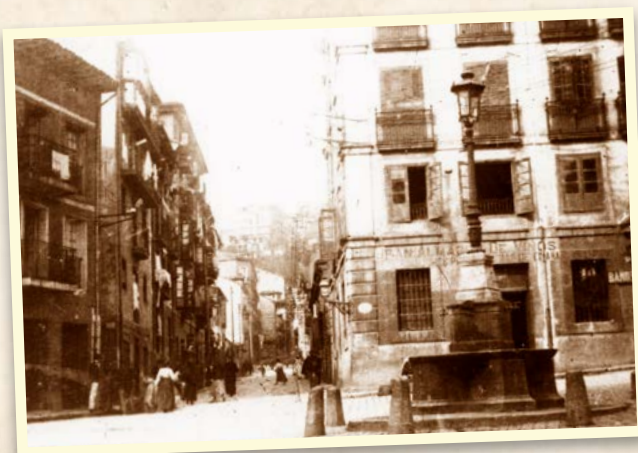
Fuente de cuatro caños a la entrada del Río de la Pila. Imagen de 1900. En ese momento había un conocido Almacén de Vinos. Posteriormente en el mismo lugar estuvo ubicado el Teatro Pereda. Foto Colección Zubieta
